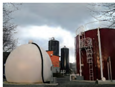
図1. メタン発酵施設 岩手県葛巻町にあるメタン発酵施設
