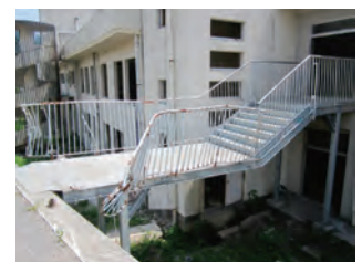
写真1-2 津波避難通路 (2011.8.10撮影)
